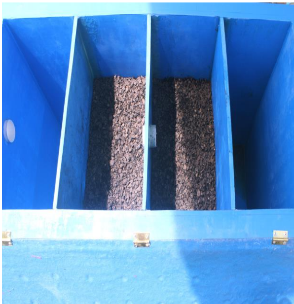
GAMBAR 4. BAK 1 TERISI CANGKANG SAWIT
