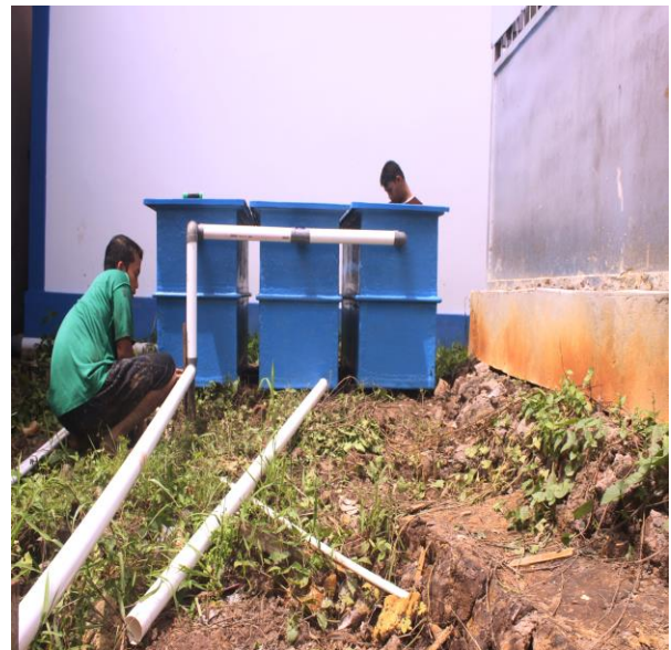
GAMBAR 4A. PENGANGKUTAN DAN PEMASANGAN BAK IPAL
