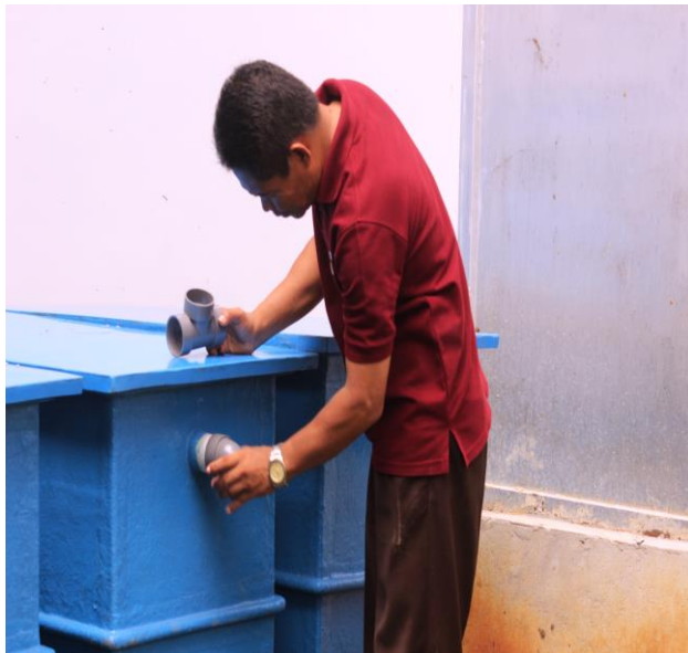
GAMBAR 4A. PENGANGKUTAN DAN PEMASANGAN BAK IPAL
