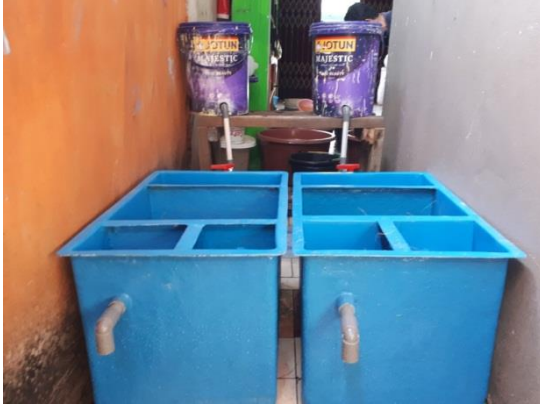
Gambar.1 Bak filtrasi dengan media serat sabut kelapa
